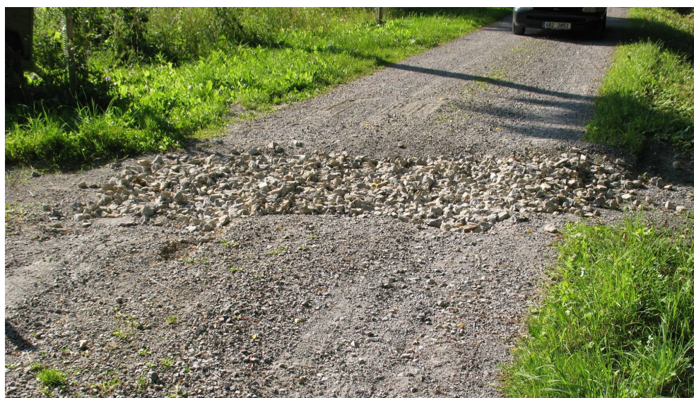
Obr. 9 Ukázka nově realizovaných příčných zemních svodnic
