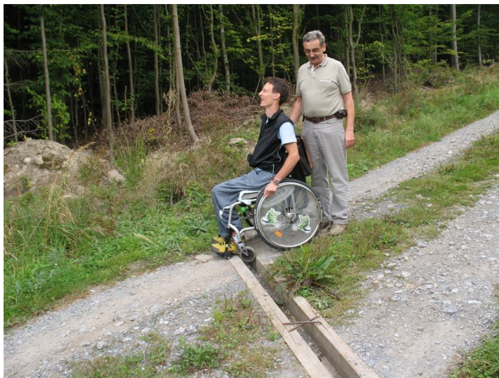
Foto 4 Lesní cesta Palaška I. - svodnice mohou způsobit potíže, s asistencí je však lze překonat
