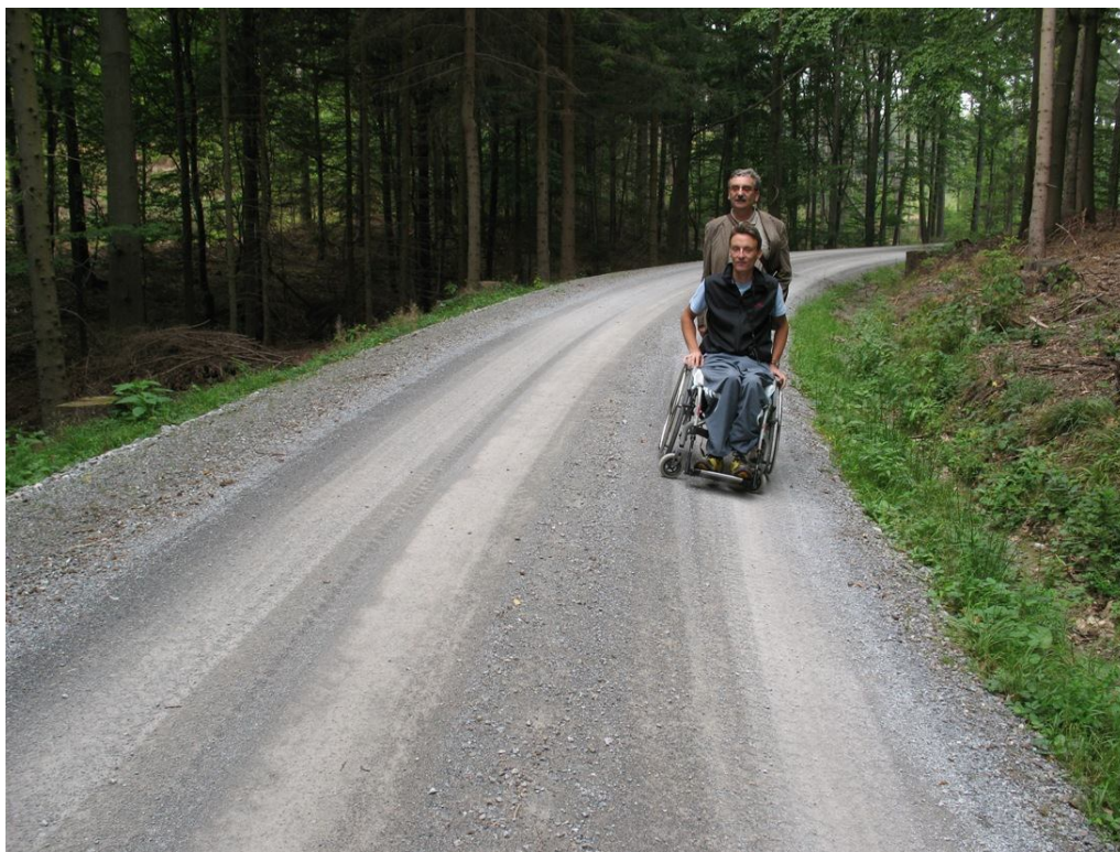
Foto 2 Lesní cesta Šindlerova - velký příčný sklon v zatáčkách ohrožuje stabilitu vozíku
