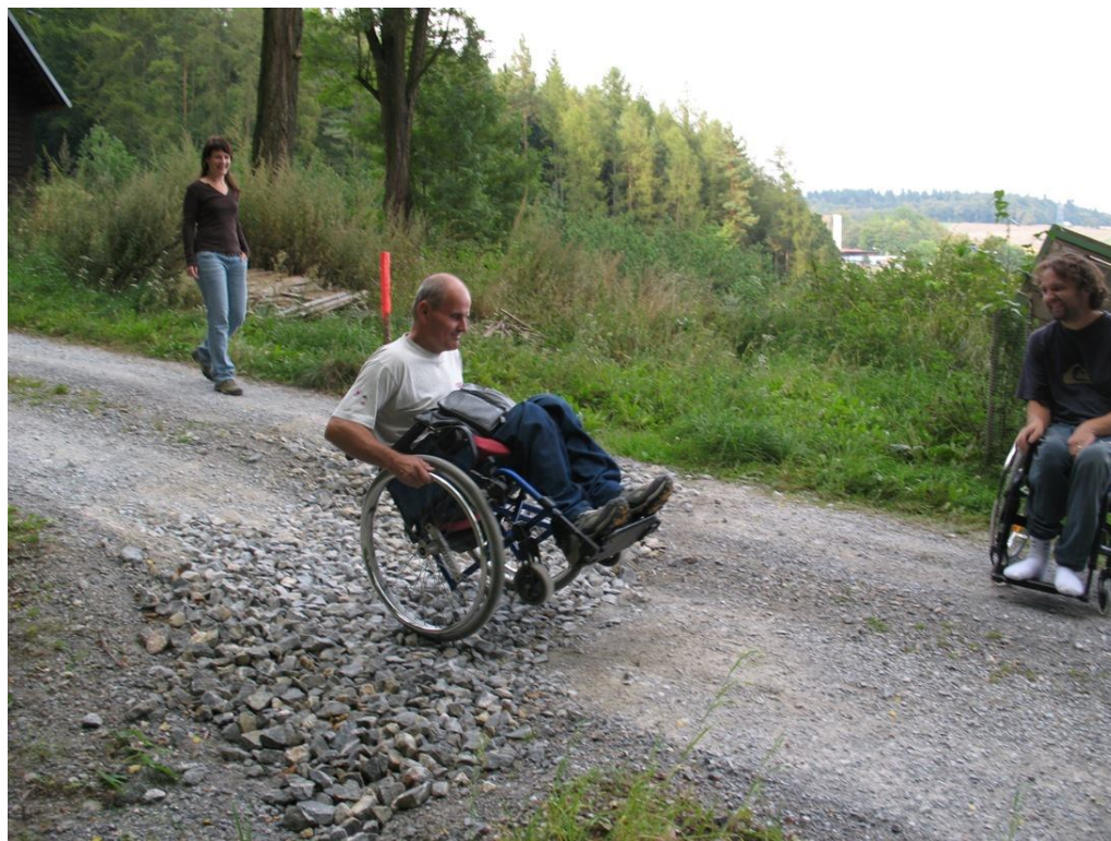
Foto 9 Lesní cesta Březinka – nejlepší způsob překonání zemní svodnice vyplněné hrubým kamenivem
