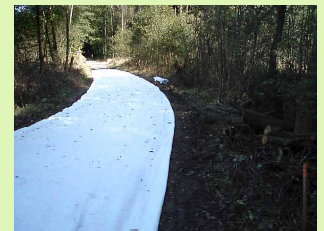
Obr. 6 Uzavření vrstvy hnědé štěpky geotextílií
