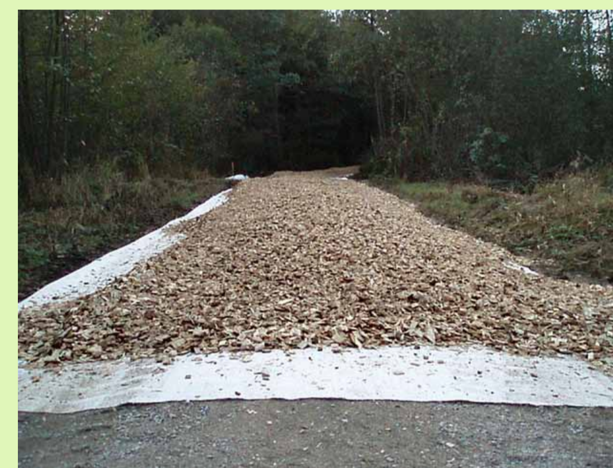
Obr. 5 Pokládka geotextílie a vrstvy hnědé štěpky
