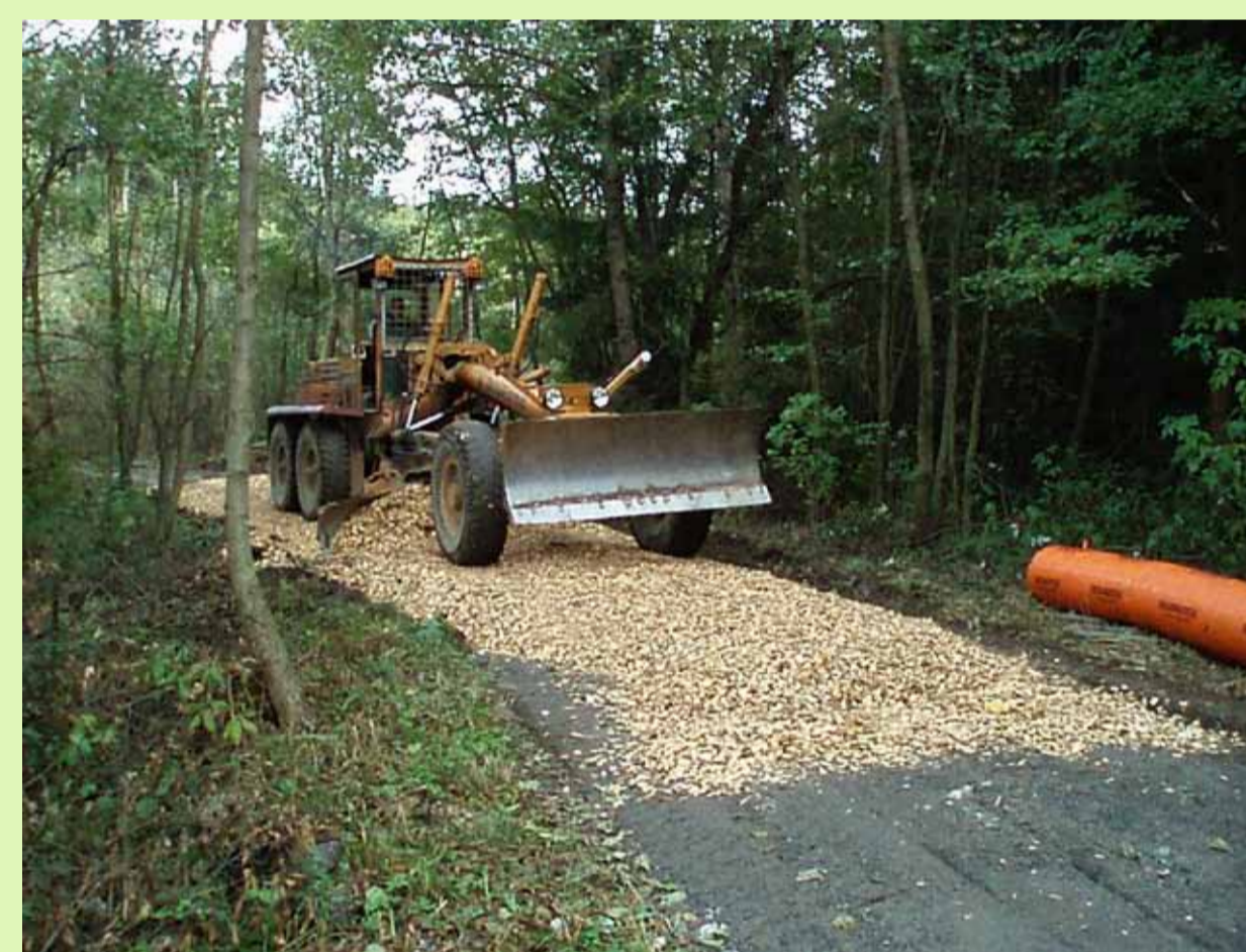
Obr. 4 Vyrovnání zemní pláně hnědou štěpkou a její použití pro tvorbu příčného sklonu
