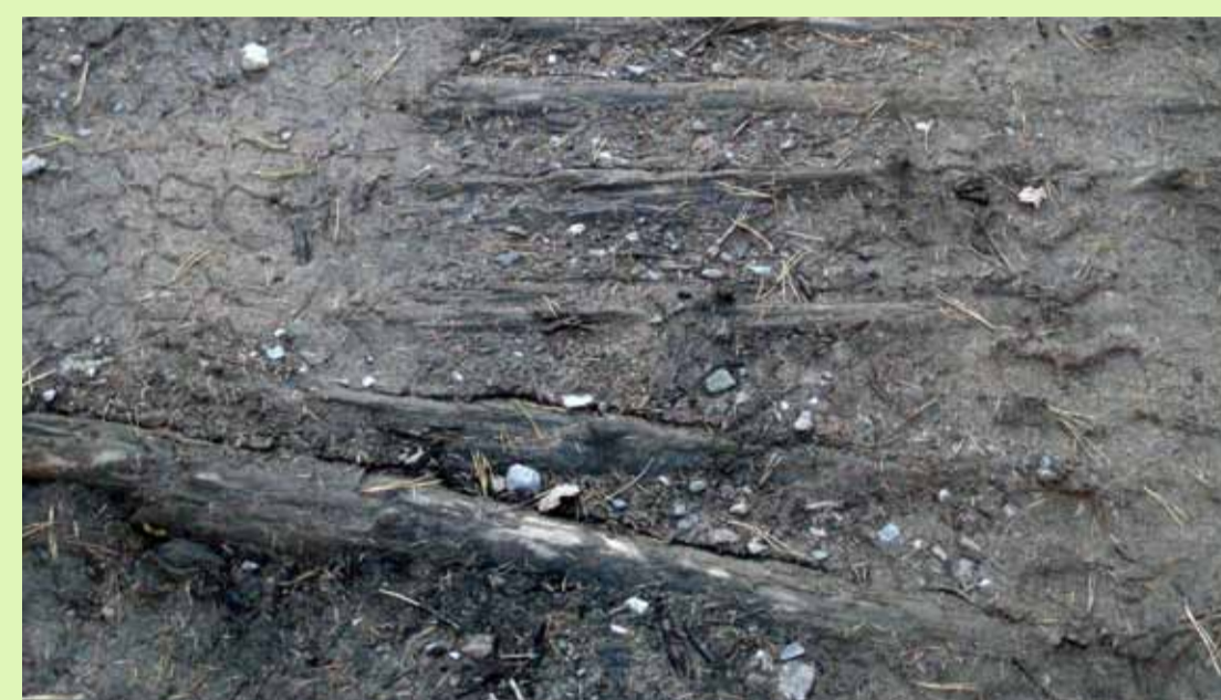
Obr. 2 Překonání podmáčených úseků lesních cest tzv. povaly
