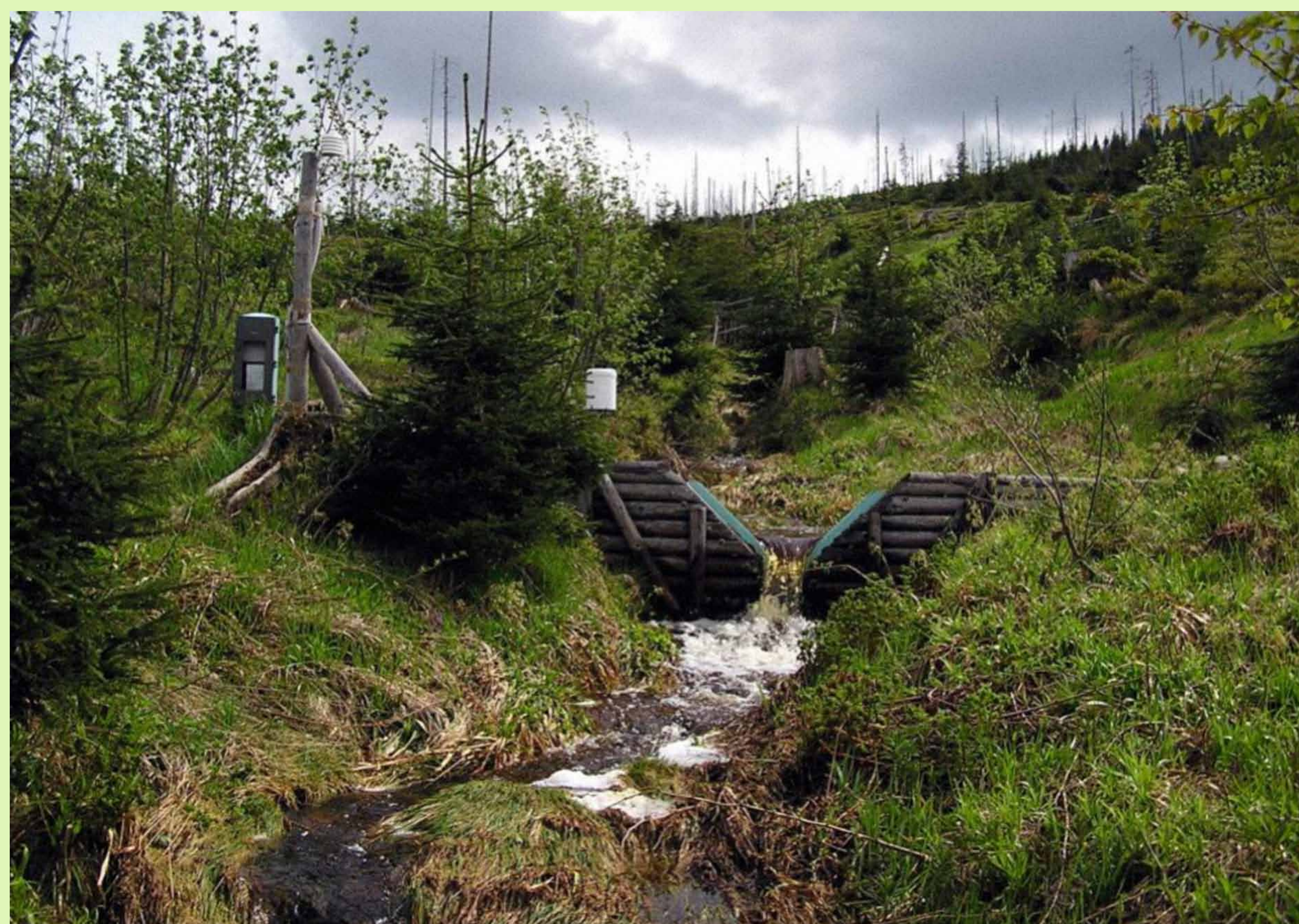
Obr. 4 Instalace měrného trojúhelníkového přelivu v přírodním prostředí. Celá konstrukce je z kulatiny, pouze hrany přelivné plochy jsou ocelové ( www.pars-aqua.cz/prelivy.htm )
