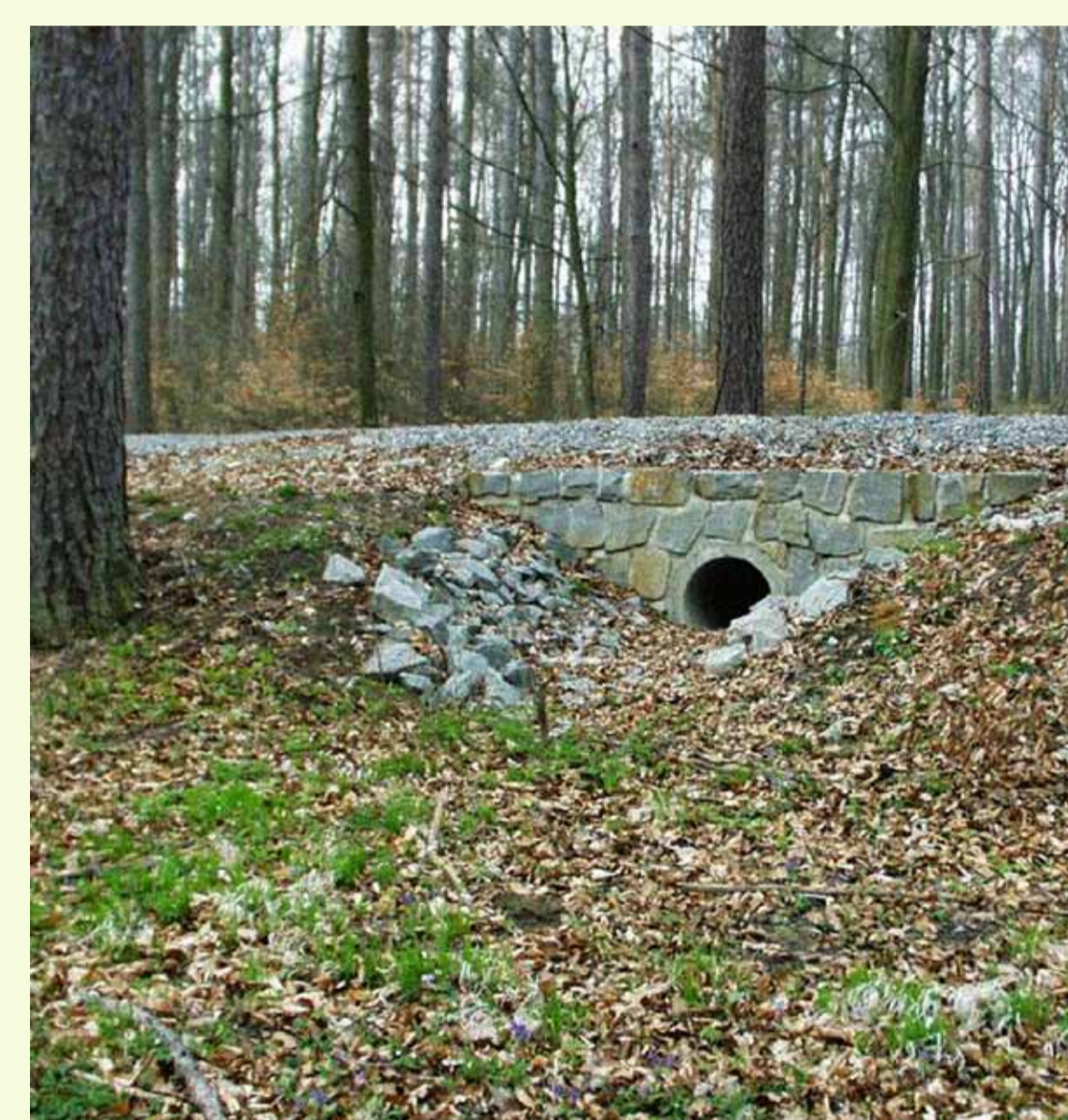
Obr. 6 Trubní propustek z železobetonových trub s čelem z kamenného zdiva
