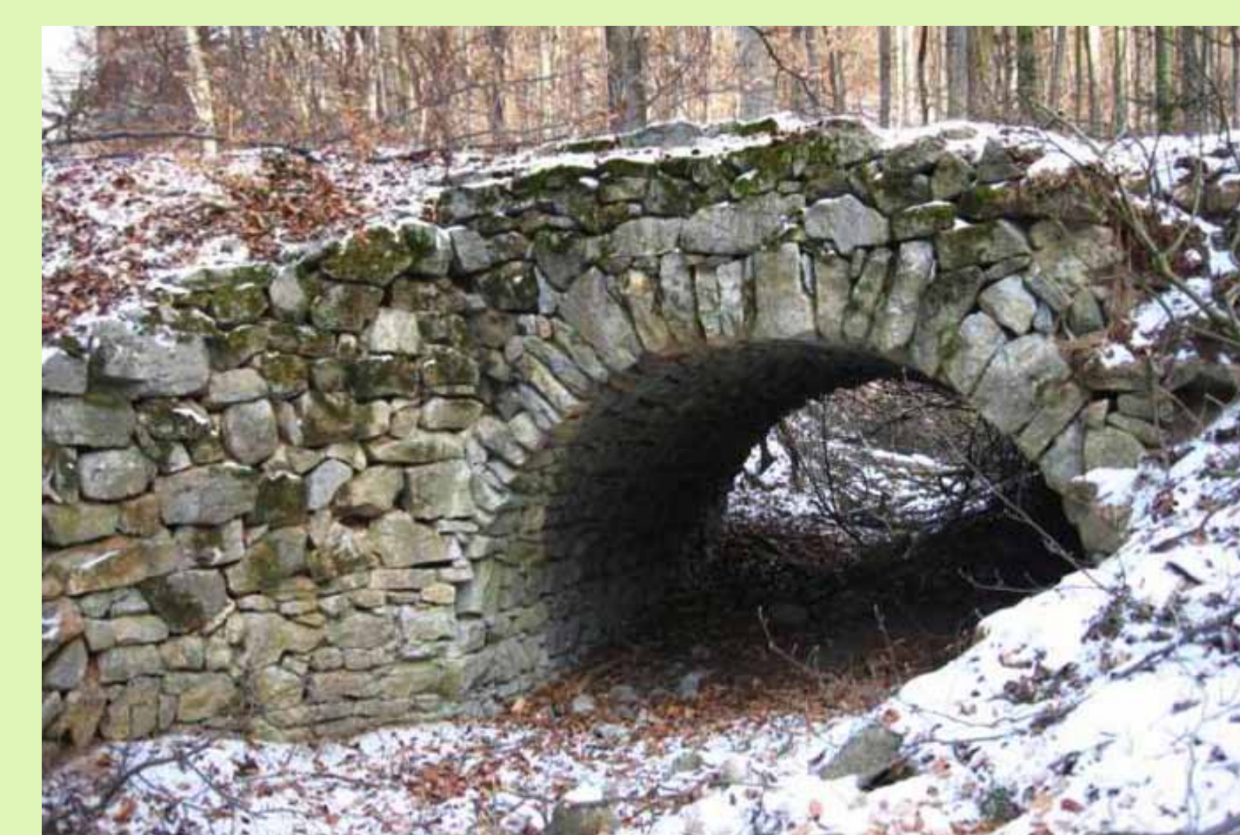
Obr. 9 Nosná konstrukce mostu klenbová
