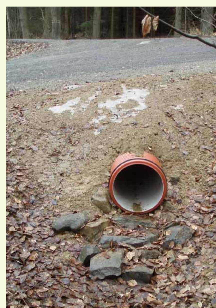
Obr. 5 Plastový trubní propustek bez čela
