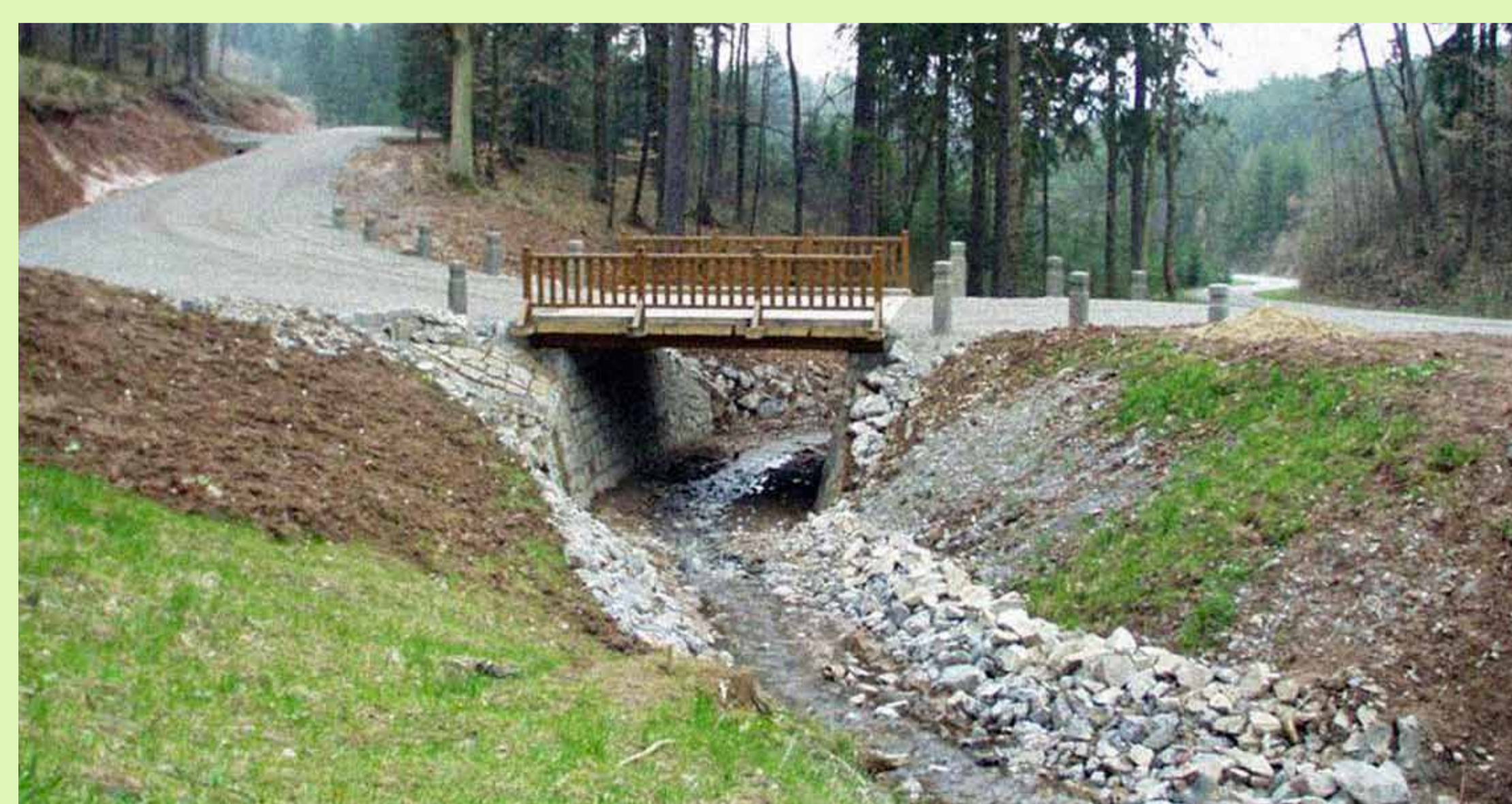
Obr. 8 Nosná konstrukce mostu přímá trámová
