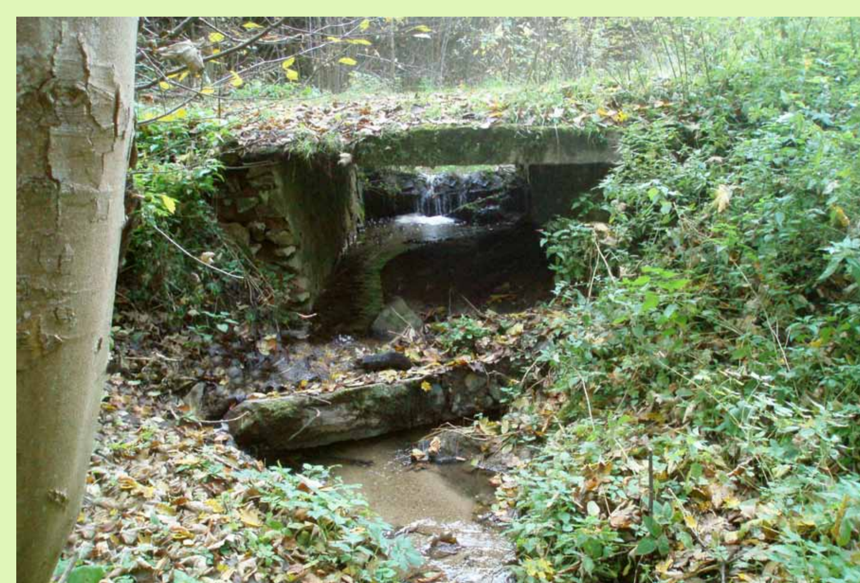
Obr. 7 Nosná konstrukce mostu přímá desková
