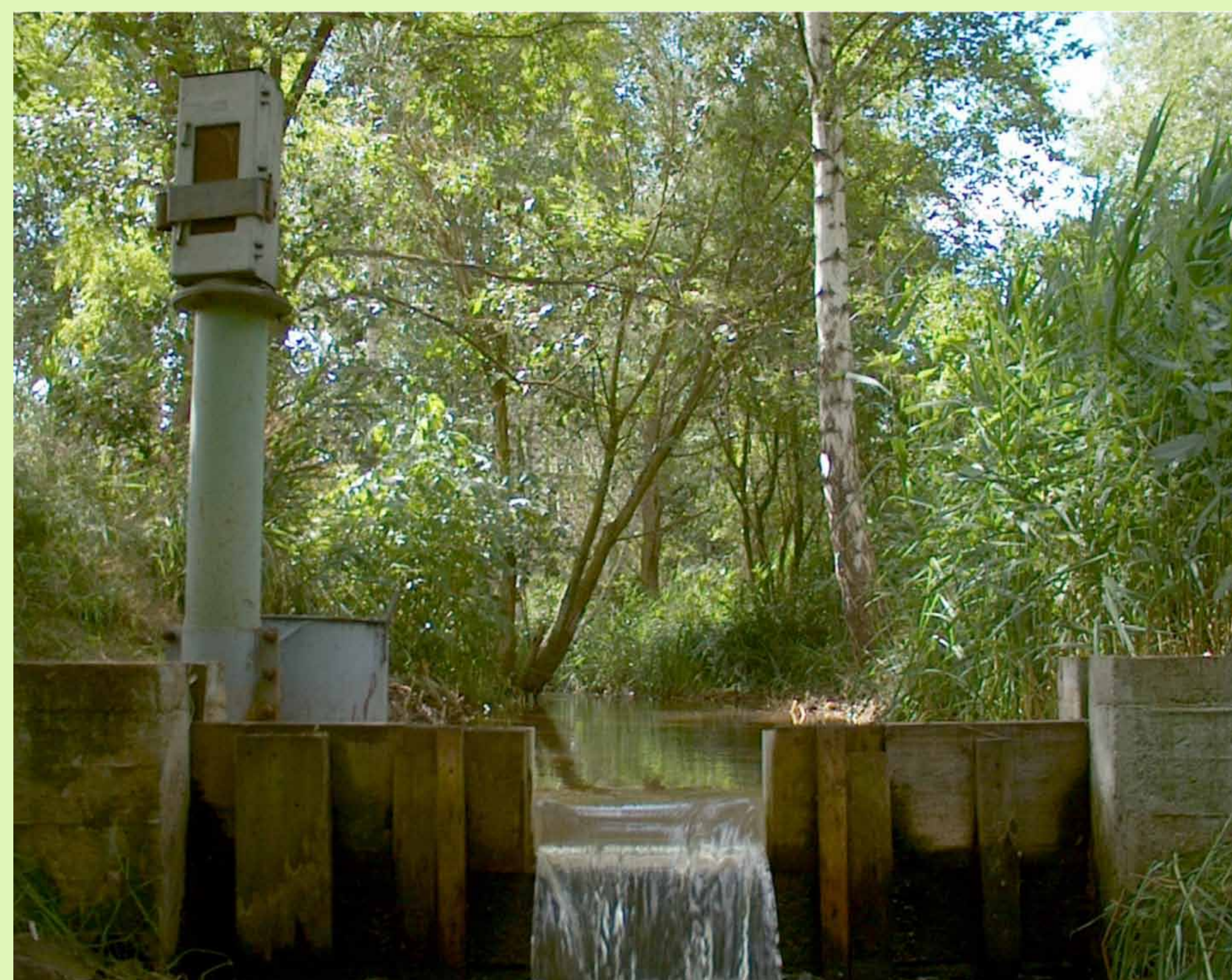
Obr. 2 Realizace Ponceletova přelivu na drobném vodním toku (www.pars-aqua.cz/prelivy.html)
