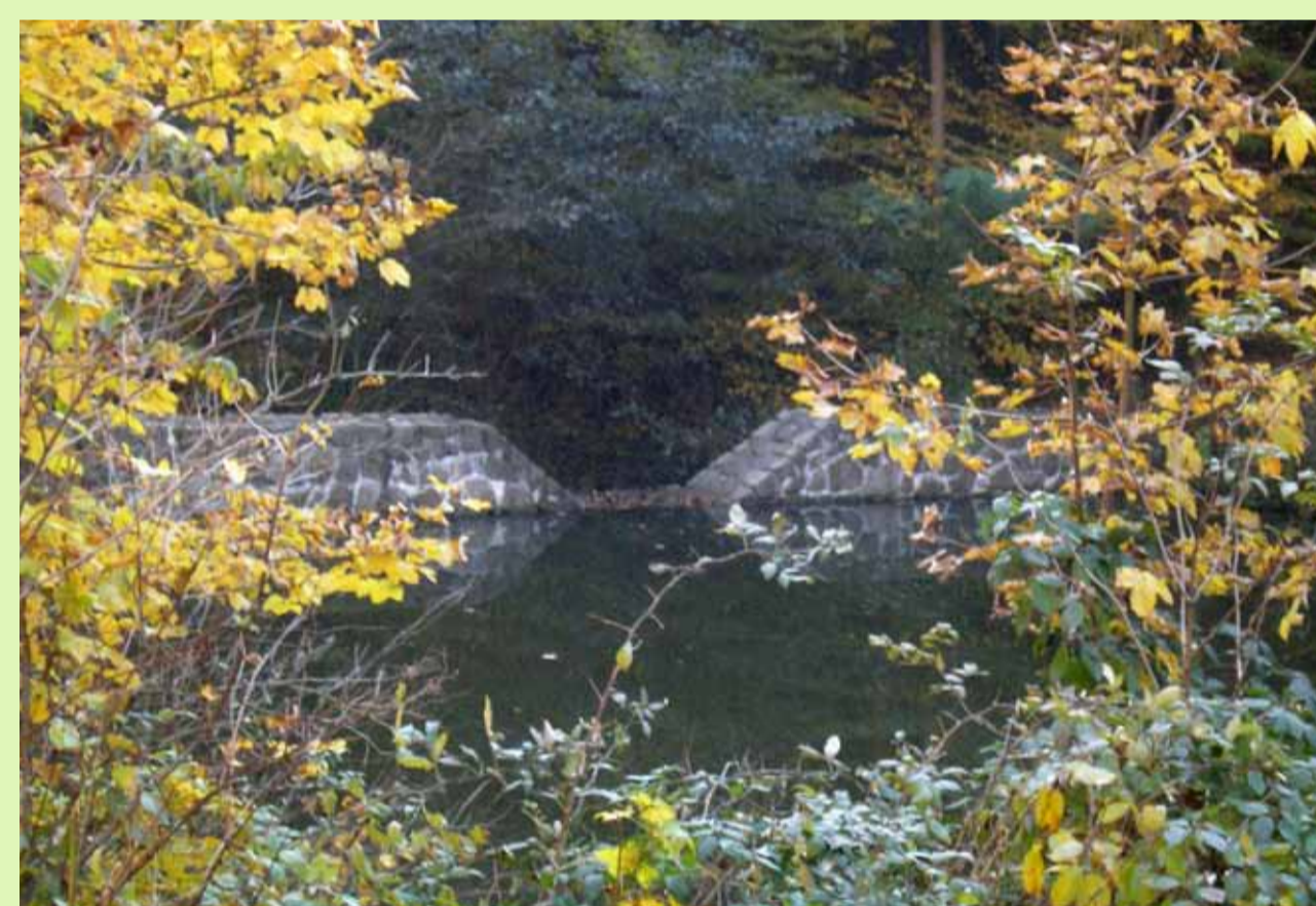
Obr. 2a Retenční prostor zděné kamenné přehrážky – zaplňný, (Melatín 2012)
