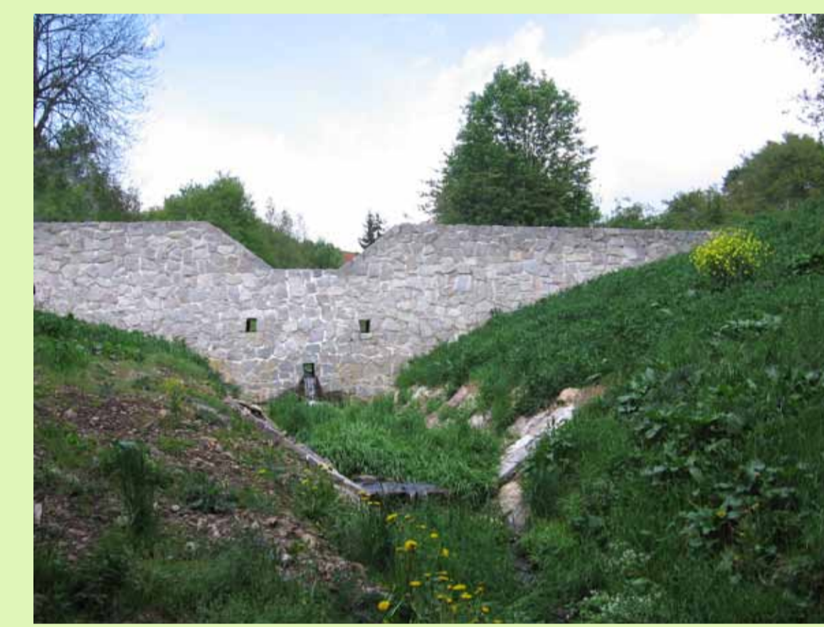
Obr. 3a Zděná kamenná přehrážka s otvory pro průtok vody, (Osiky 2007)
