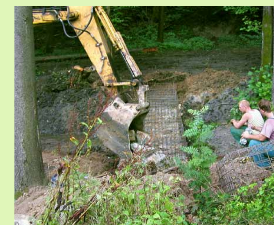
Obr. 4a Plnění košů mechanizací (Melatín 2002)
