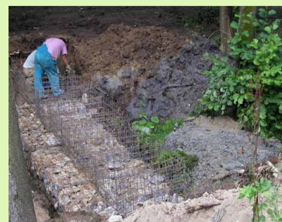
Obr. 4 Tvarování košů – pro naplnění kamenivem (Melatín 2002)
