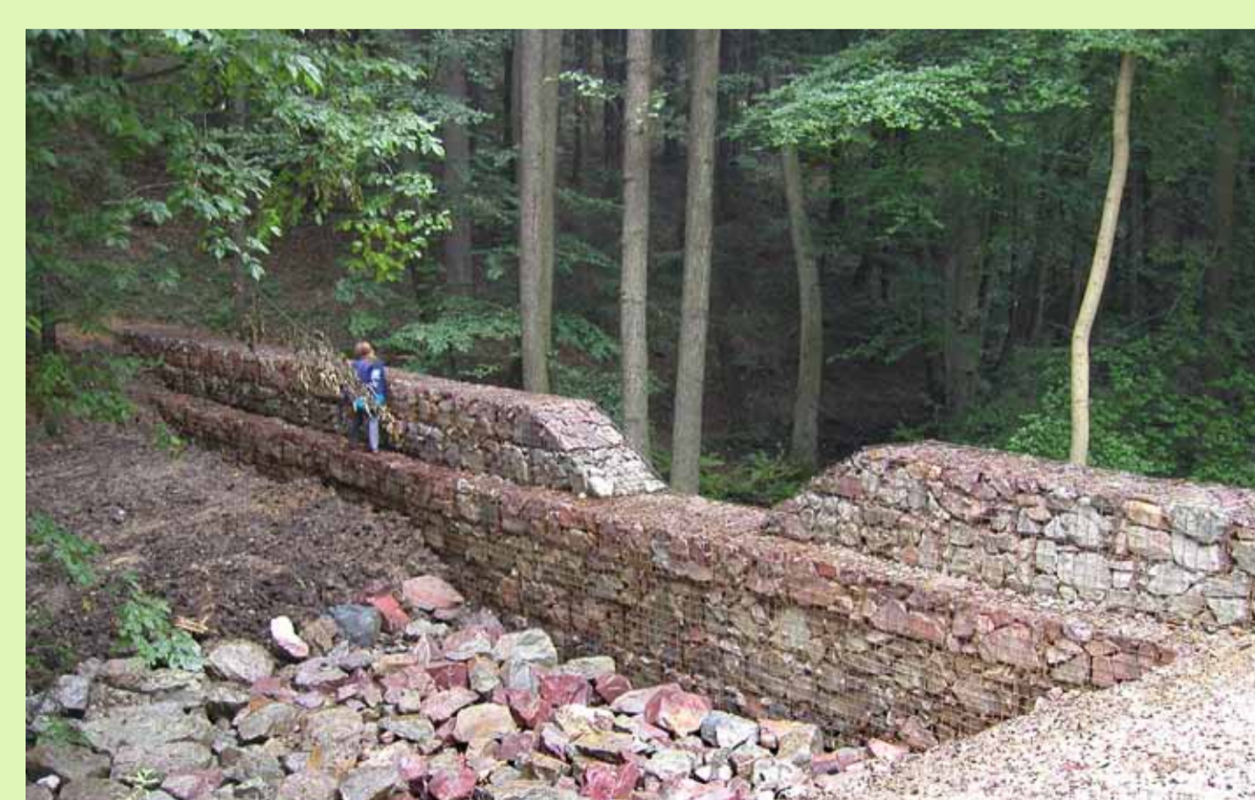
Obr. 4c Dokončená drátokamenná přehrážka, těsně po výstavbě. Opevnění spadiště pod přehrázkou kamenem (Melatín 2002)
