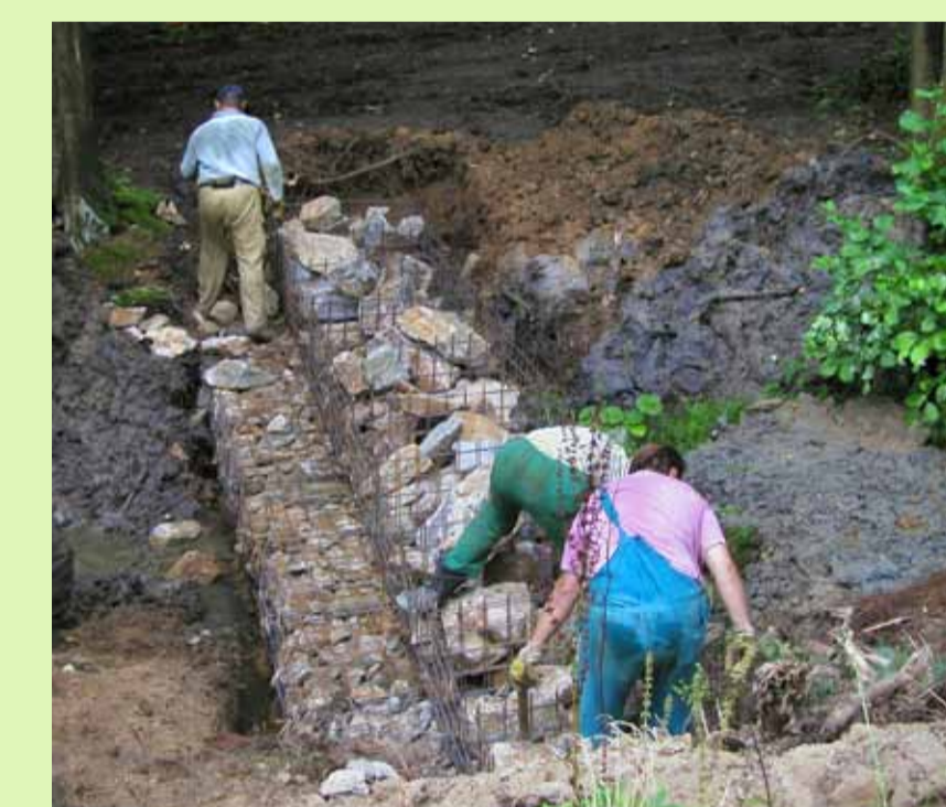
Obr. 4b Ruční rovnávání kamenů v gabionech (Melatín 2002)
