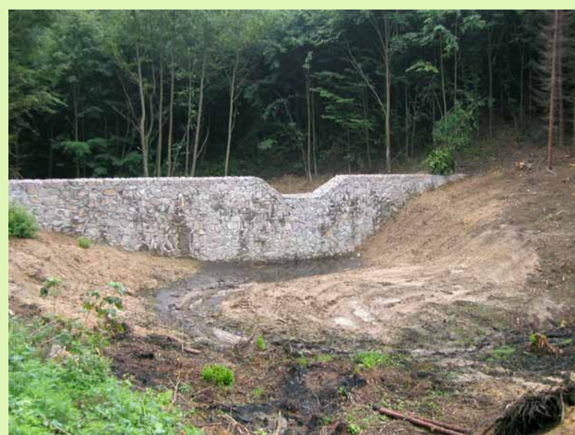
Obr. 2 Retenční prostor zděné kamenné přehrážky – nezaplňný, (Melatín 2012)
