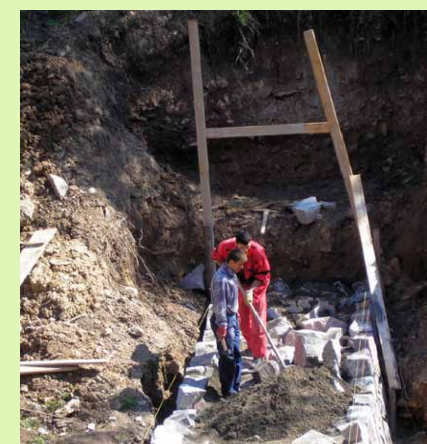
Obr. 3 Zděná kamenná přehrážka při výstavbě, (Osiky 2006)
