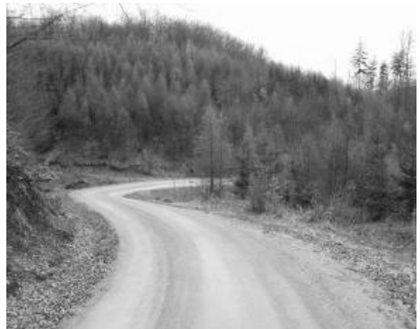
Obr. 2 Rekonstrukce krytu mechanicky zpevněným kamenivem
