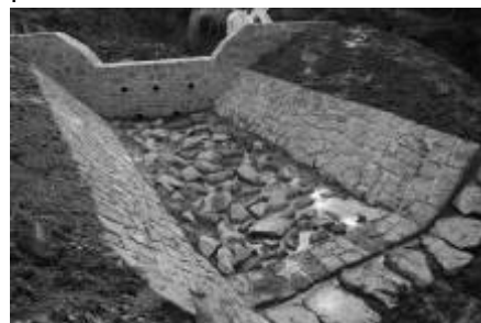
Obrázek 6: ukázka přehrážky se zdrsněným spadištěm.
