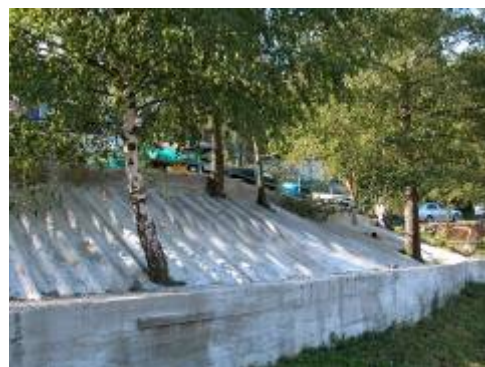
Obrázek č. 5 Vybudování zpevněného parkoviště, které bylo „rozšířeno“ i na další plochy (VAS, a.s.)
