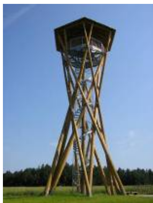
Obr. 1: Dřevěná rozhledna Borůvka – vzhledově poutavá i technicky zajímavá stavba
